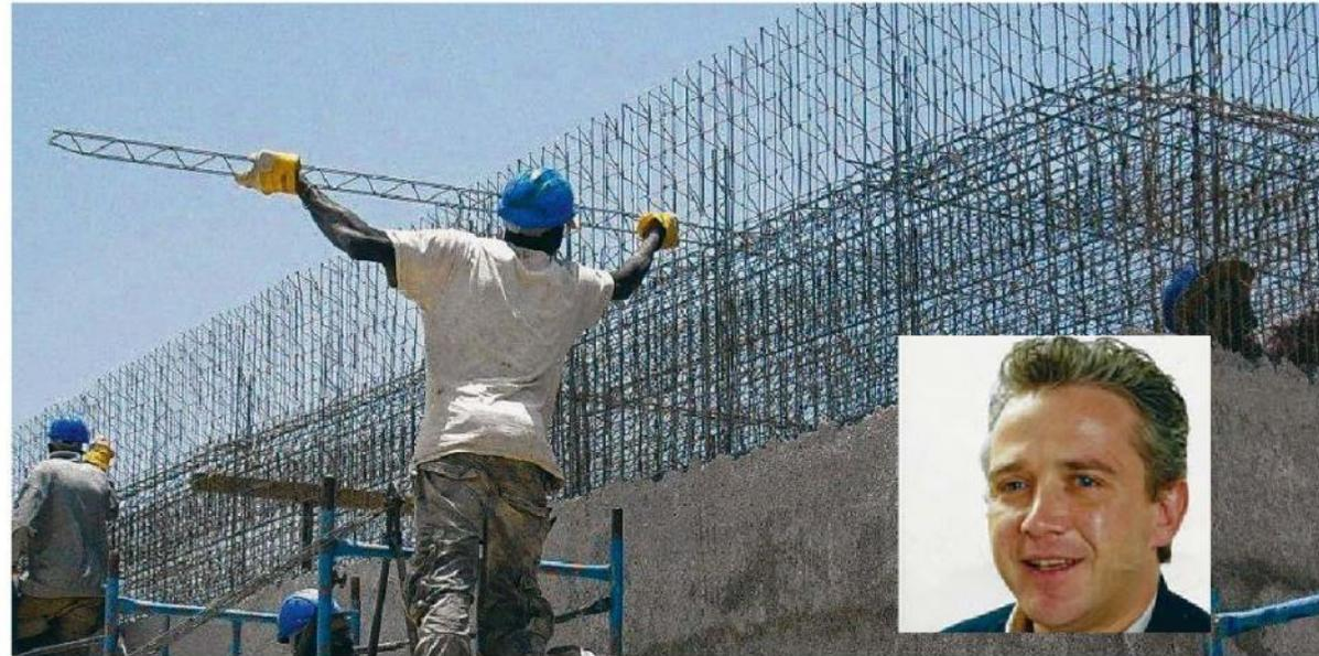
Sur le chantier, le système s'assimile à un vaste treillis dans lequel on vient pomper du béton allégé. En médaillon, Angelo Milioto. © D.R.
